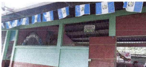
Foto 7: Pintura de muros exteriores e interiores en el centro educativo
