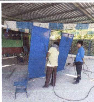
Foto 3: Mantenimiento de estructura (lijado, cambio de tubo, cepillado, sugeciones, aplicación de pintura)
