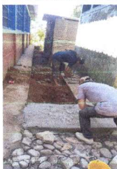
Foto 5: Sustrucción de piso de concreto en baños
