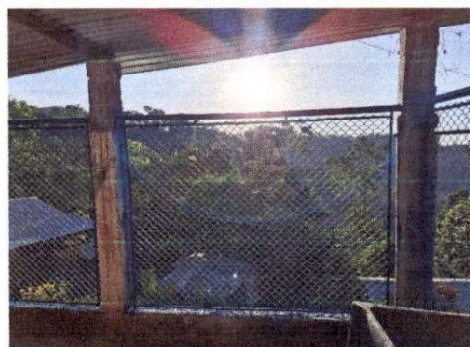
Foto 10: Reparación de tubo HG y malla galvanizada en el perímetro del centro educativo.
