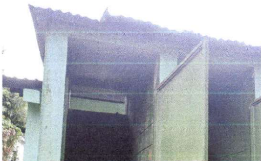
Foto 1: Sustrucción de lámina, por lamina troquelada en baños
