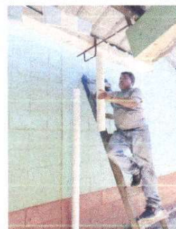
Foto 6: Reparación de bajada de agua pluvial, tubo pvc 3" en el corredor de la escuela
