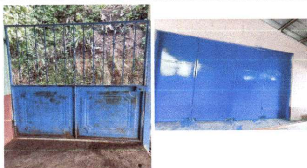
Foto 9: Mantenimiento de portones de metal en ingreso de la escuela y separación de aula
